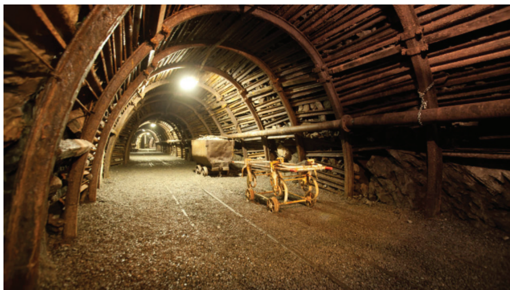
Galerie principale dans une mine de charbon.
